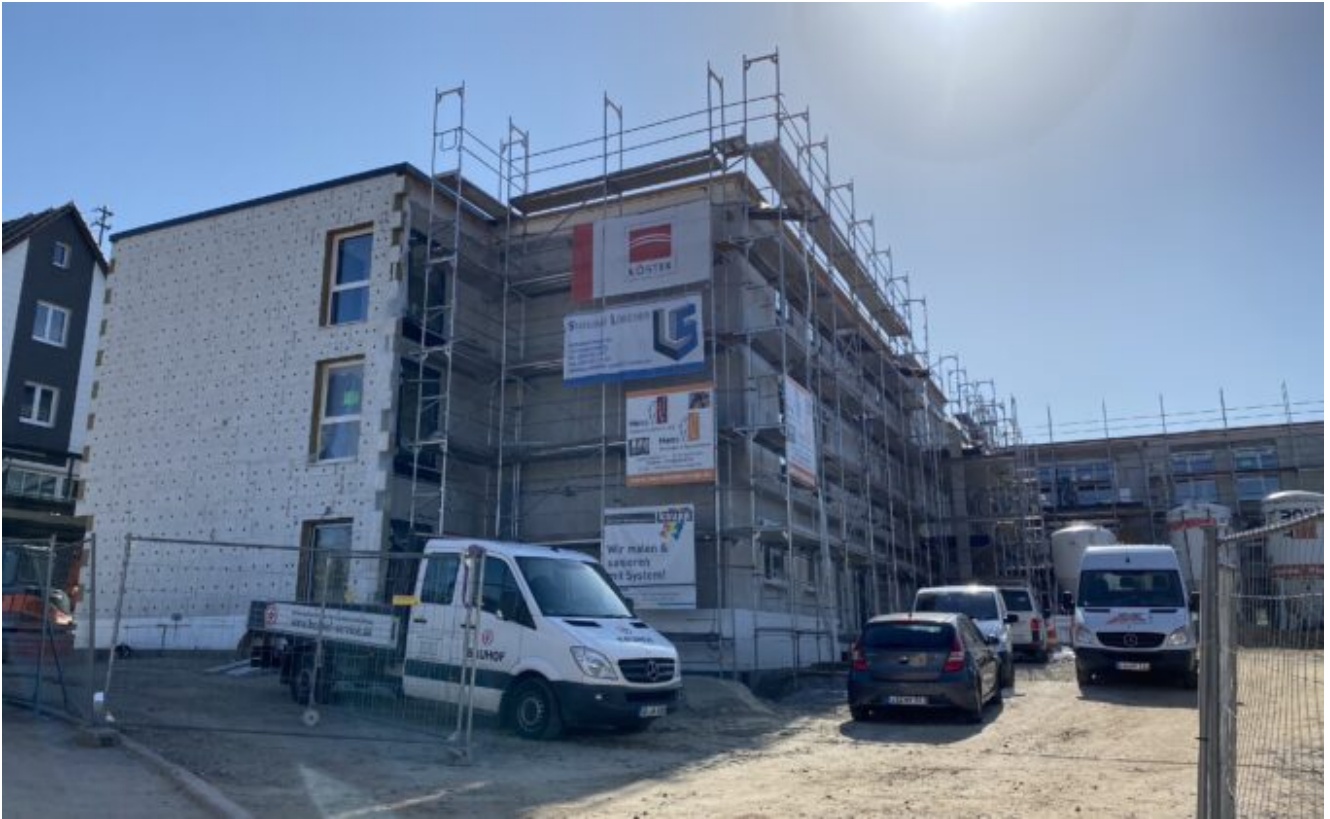
Bild der Baustelle. Foto: gg
