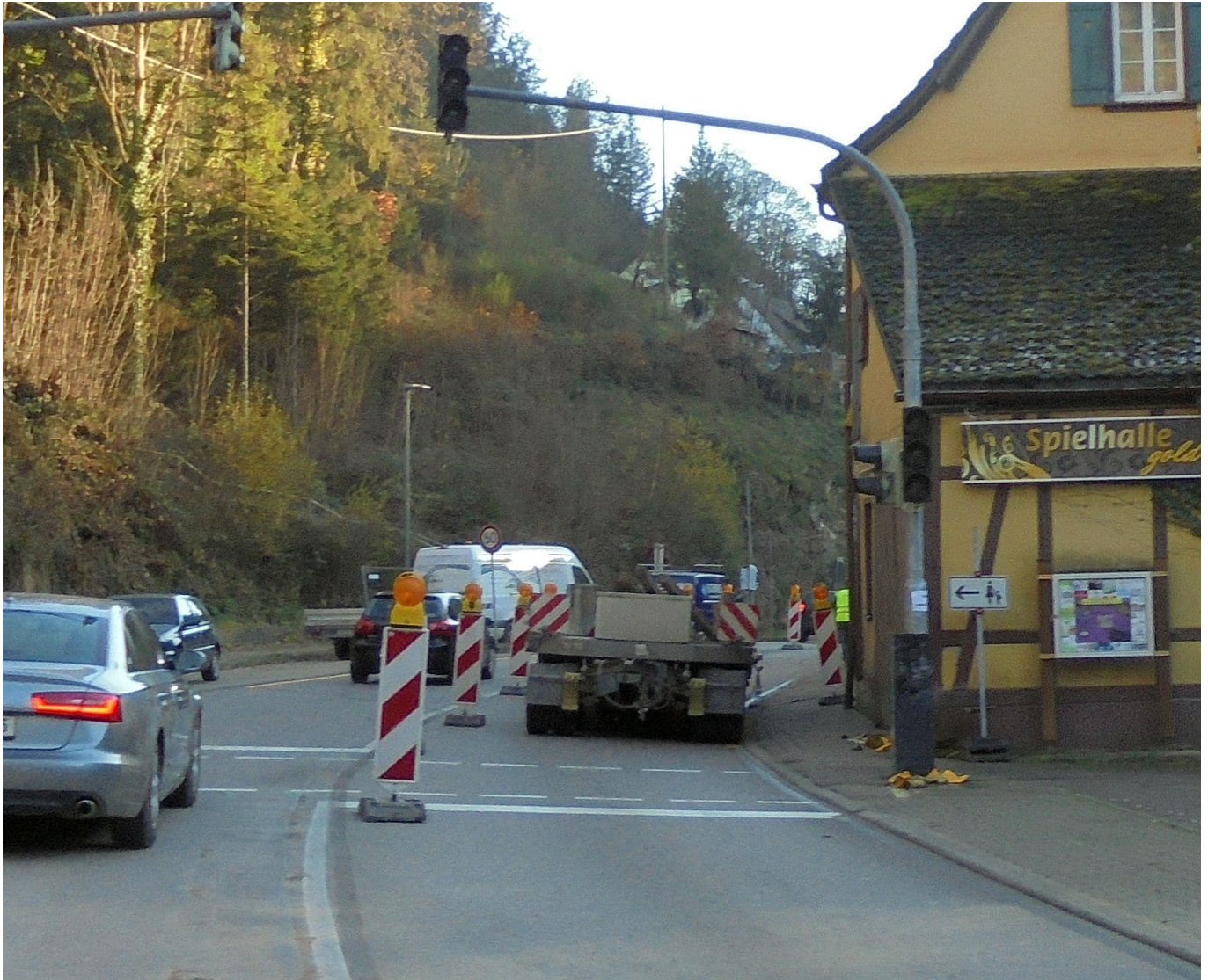
Bauarbeiter transportieren die Betonelemente bei der Alten Mühle ab. Foto: him
