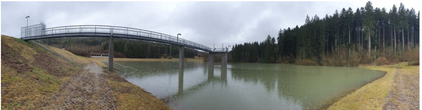
Der Probestau in Neufra läuft. Am Montagmittag ist das Becken knapp zur Hälfte gefüllt. Fotos: Peter Arnegger
