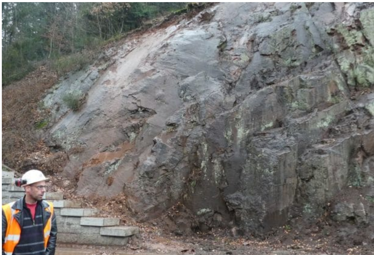
Thomas Baumann zeigt die glatte Wand nach Beräumung
