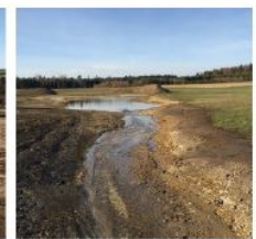
Datum nach Fertigstellung Bauteilschnitt 1 aufgenommen am 14.05.2017
