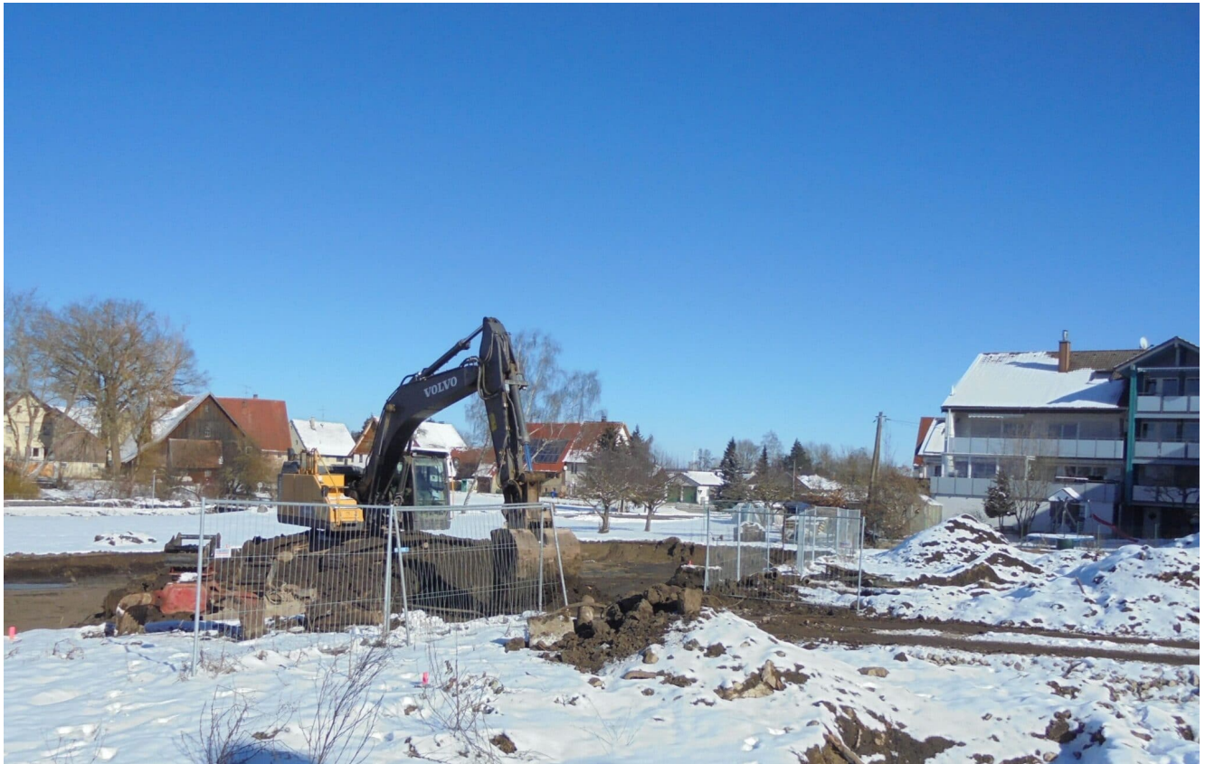
Baubeginn in Waldmössingen.
