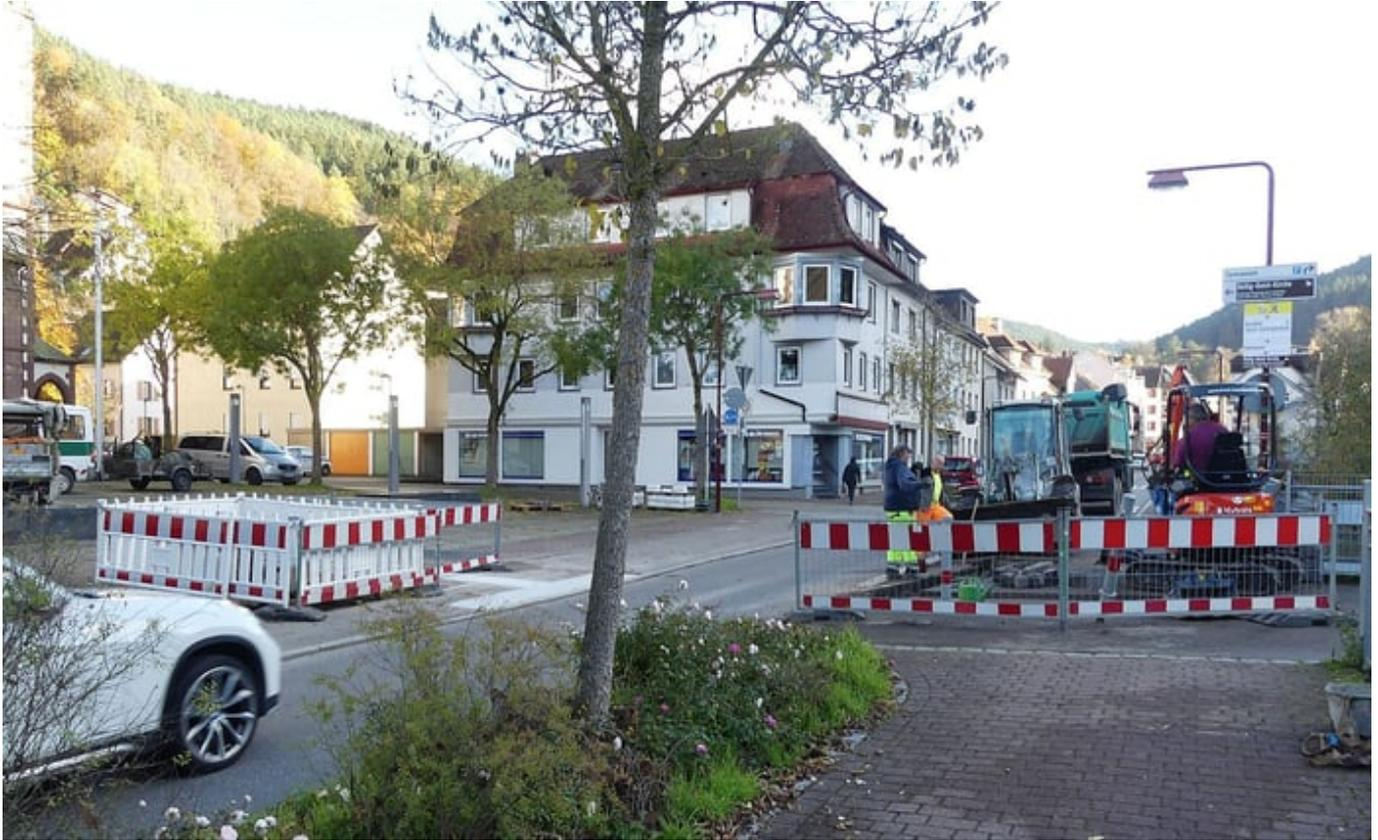
Ein erstes Ergebnis des 1000-Zebrastreifen-Wettbewerbs ist sichtbar. Beim Gymnasium haben Bauarbeiter dieser Tage Stromkabel verlegt und Blindenleitstreifen im Gehweg angebracht. Noch in diesem Jahr soll der lang ersehnte Fußgängerüberweg beim Gymnasium fertig gestellt werden, wenn das Wetter mitspielt.
